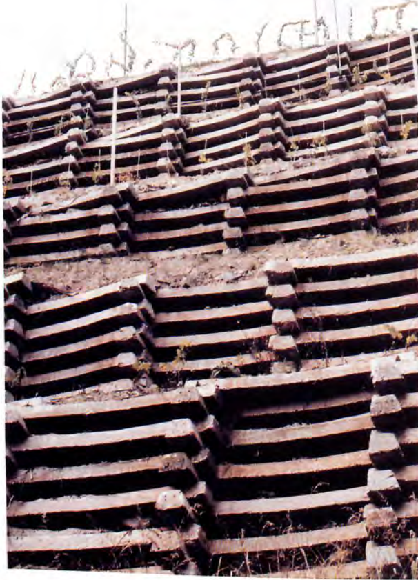
Links: Befestigungen im Moränengelände des Eschenbaches unterhalb des Vorhauser Hofes; rechts das kümmerlich fließende, stark verschmutzte Wasser des Eschenbaches. Der oben sichtbare Rost dient als Auffangkanal für das Wasserrohr und hält den Unrat zurück. In der Mitte der Mauer – wie der Nabel eines Lebewesens - der Anschluss für die Bewässerungsrohre.
