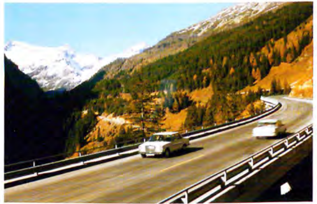
Die Felbertauernstraße. 1967 eröffnet, verbindet nun innerösterreichisch den Bezirk zu seiner Landeshauptstadt Innsbruck.
