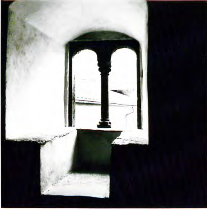
Romanisches Doppelbogenfenster im Obergeschoss des Bergfrieds von Schloss Bruck.
