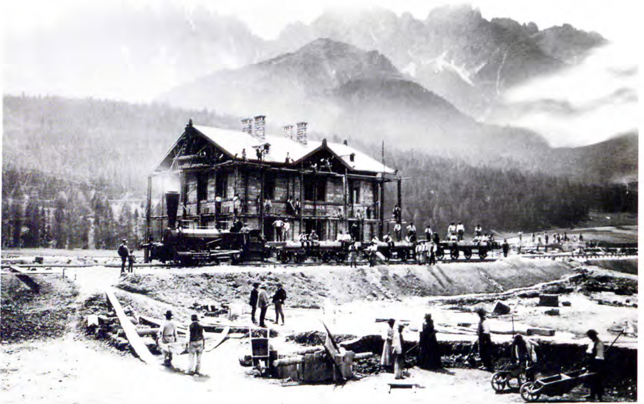
Zehn Monate früher als geplant konnte die Pustertalbahn – hier die noch im Bau befindlichen Stationen von Lienz ( Bild auf vorhergehender Seite) und Innichen sowie die Brücke über die Eisackschlucht – bereits im Herbst 1871 seiner Bestimmung übergeben werden. (Tiroler Landesmuseum Ferdinandeum, Historische Sammlungen; Repro: Meinrad Pizzinini)
