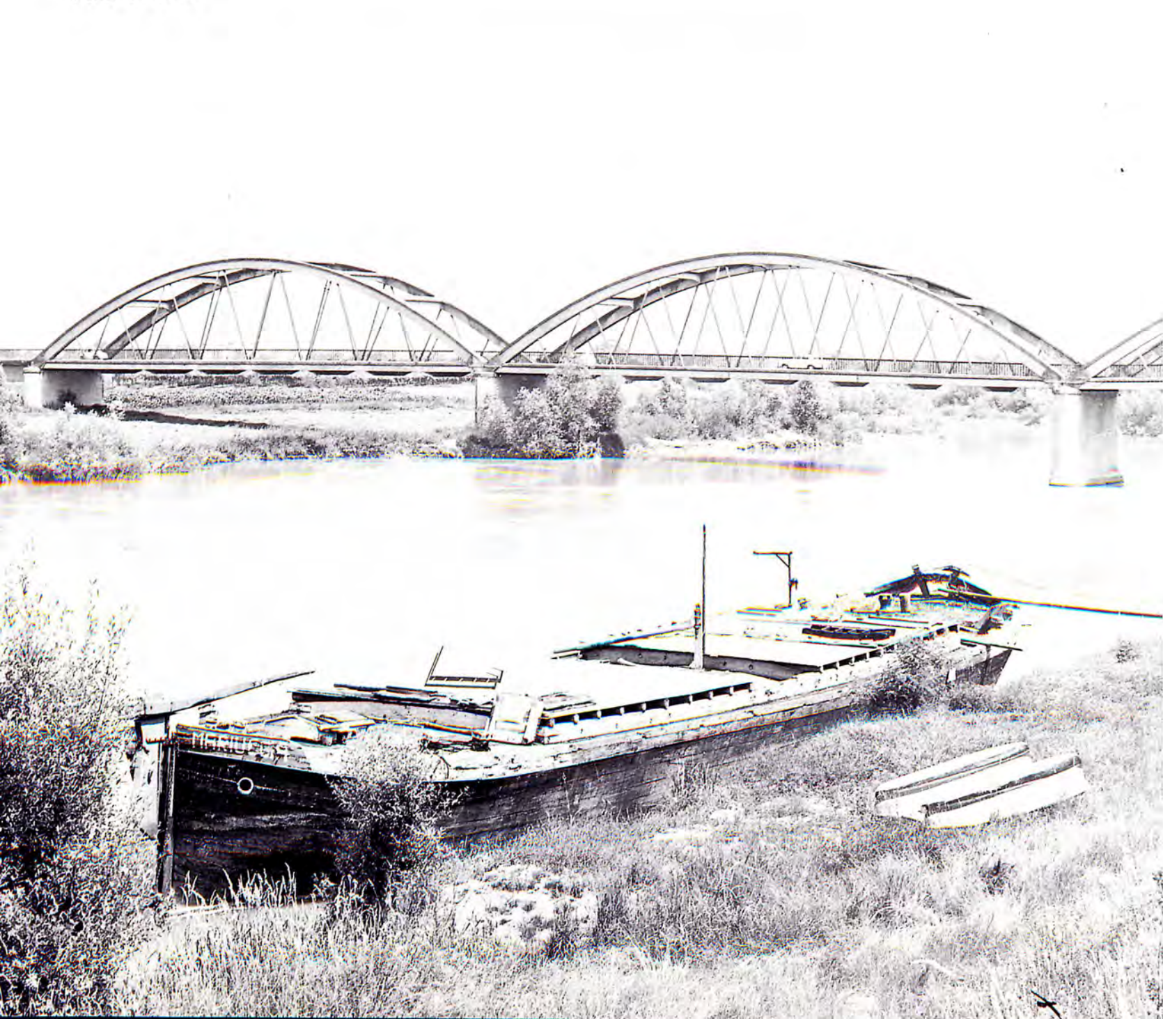
Ponte di Ronco
