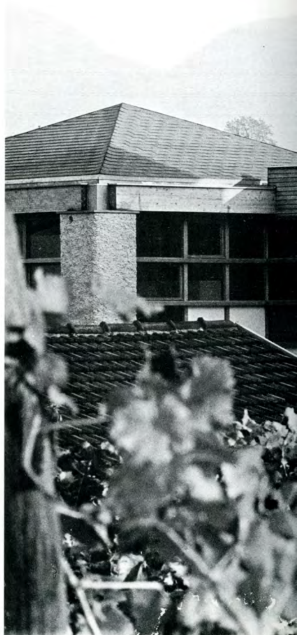
156 - 157 Erweiterungsbau Mädchenschule «Mariengarten». St. Pauls-Eppan, 1977, 6 Holzdächer über fließendem Unterrichtsbereich. In den hohlen Eckstützen sind die Installationen geführt.
