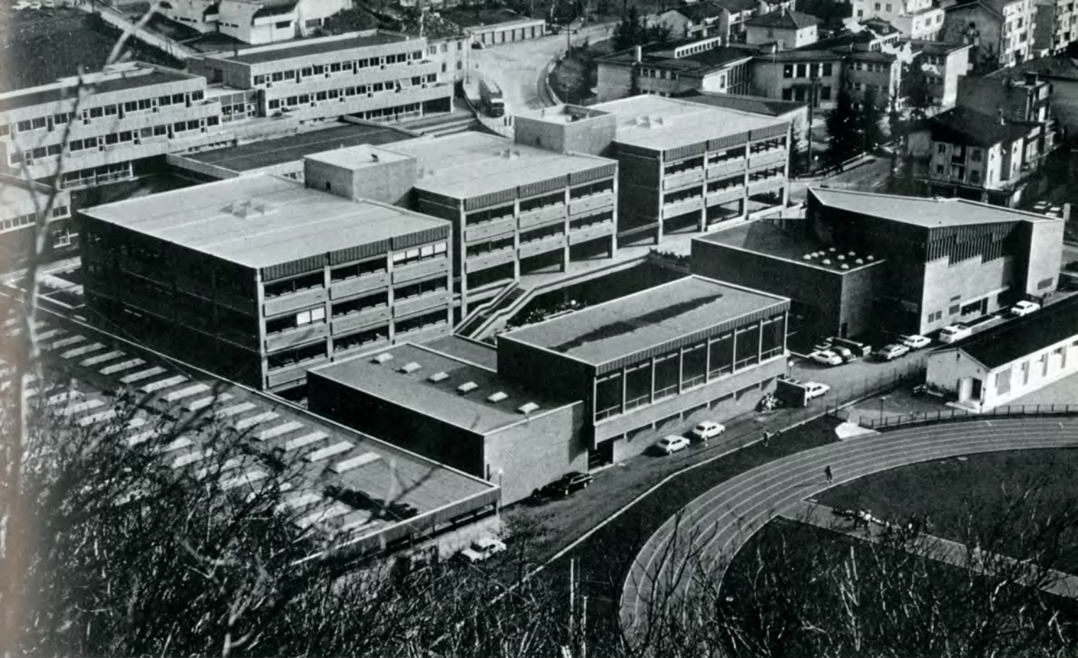
225 - 226 - 227 - 228 Italienische Berufsschule für Handel, Handwerk und Industrie in Bozen-Haslach. Backsteinbau. Die Bilder: Kleiner Konferenzraum, Westansicht und die beiden unteren Stockwerke.
