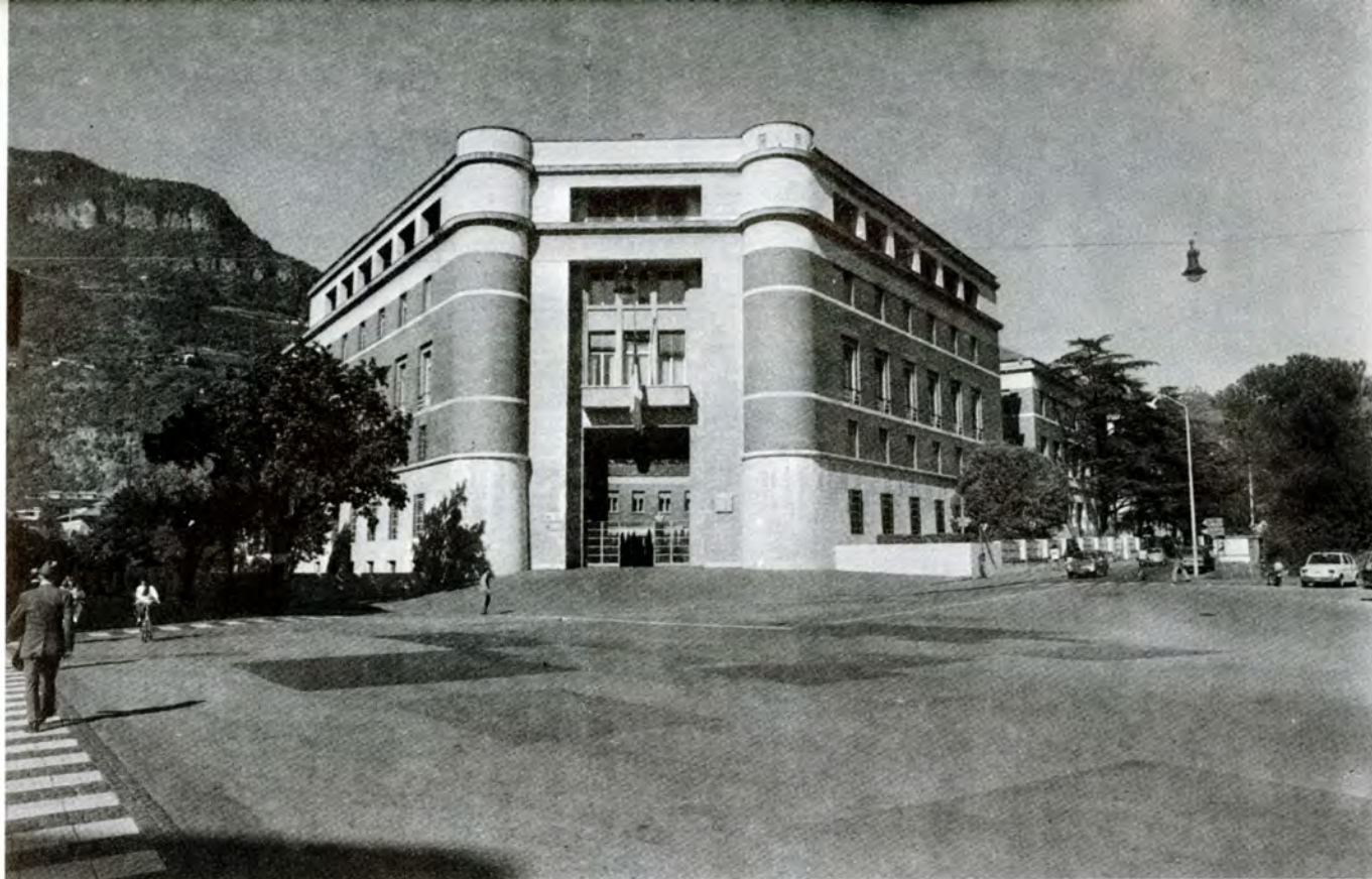
146 Armee-Kommando-Gebäude Bozen, 4. November-Platz. Arch. Piacentini, 30er Jahre.
