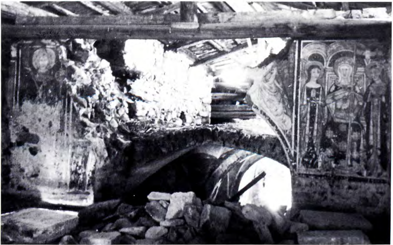
Abb. 6: Zerstörte Ostwand in der oberen Vorhalle, vor 1951. Aus dem Archiv des Landesdenkmalamtes Bozen.
